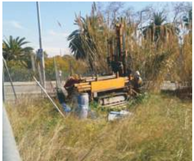
Fotografia 10. Execució del sondeig S-1R.
