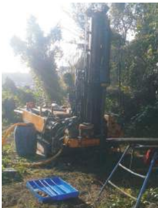
Fotografia 10. Execució del sondeig S-4R.
