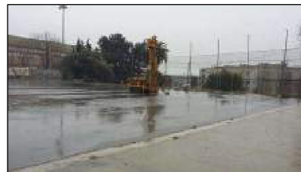
MÀQUINA REALITZANT EL SONDEIG S-2.
