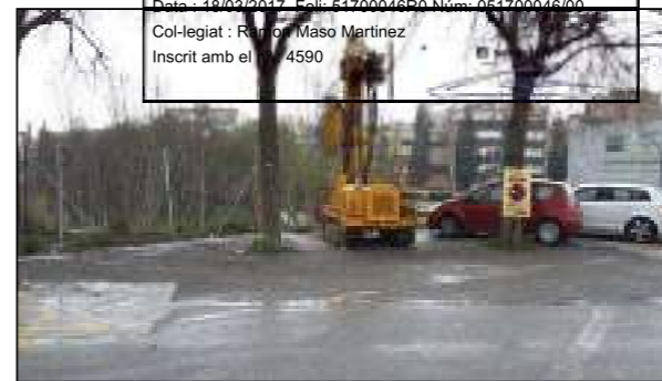
MÀQUINA REALITZANT EL SONDEIG S-1.
