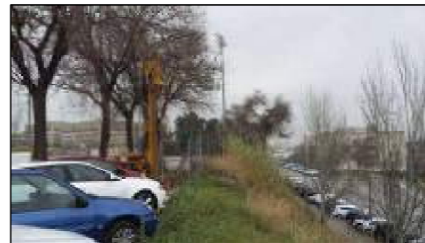
MÀQUINA REALITZANT EL SONDEIG S-1.
